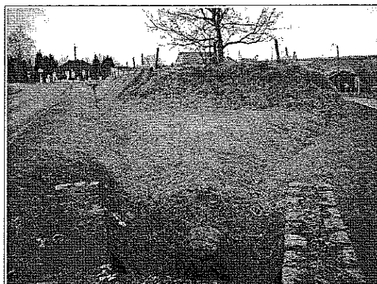
Réalisation d'ouvrages permettant de canaliser les eaux au Sud Est de la commune de Craonnelle
